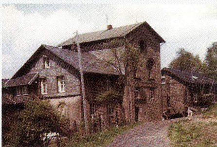
Schachtgebäude der Grube Apfelbaumerzug
