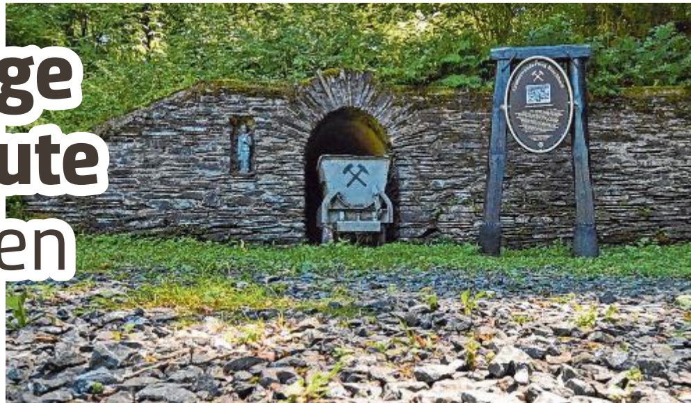
Der Venus-Charlotten-Stollen wurde einst auch von Hugo Irlich und seiner tatkräftigen Truppe neu aufgebaut. Ein Bergmann ist in die Mauer eingelassen. Und der Grubenwagen steht bereit.
